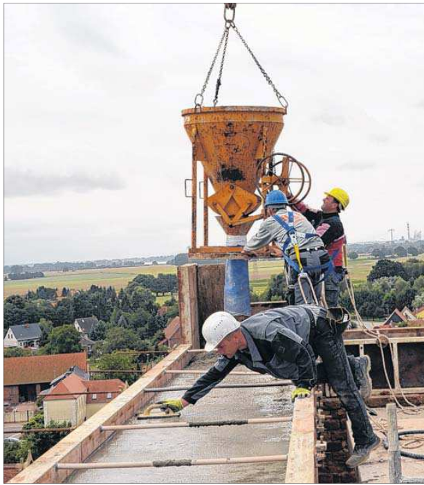
Uwe Petschik und Bernd Glaser leeren den am Kran hängenden Betonschüttkübel, Karsten Wolf glättet vor den Beton des Ringankers. Foto: Ingo Freihost
