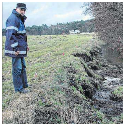
Arno Mahlke steht nach dem Winterhochwasser im Vorjahr an der erneut abgerutschten Grabenböschung. Archivfoto: Ingo Freiherst
