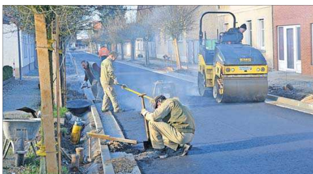
In der Sandauer Stavenstraße wurde der Asphalt in zwei Schichten aufgetragen.
