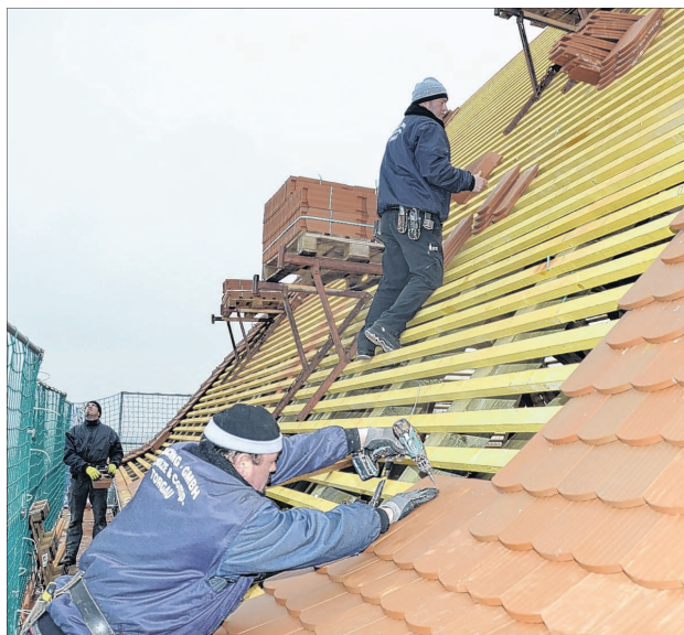
Die Dachziegel im schweren Kirchenbiber-Format werden von den Dachdeckern aus Torgau in Mörtel gelegt und verschraubt. Foto: Ingo Freiherst
