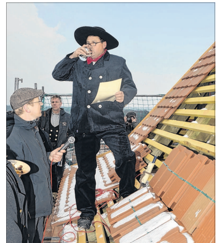
Prost! Der Richtspruch ist verlesen, Zimmermann Karsten Pattschull zerschmettert das Glas anschließend auf den Dachsteinen.
